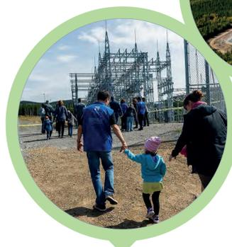
Le **poste de raccordement** augmente la tension au niveau requis afin de pouvoir relier le réseau collecteur des parcs éoliens au réseau d'Hydro-Québec.
